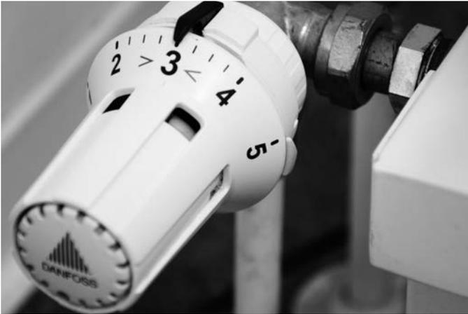
Thermostatventil zur Regelung der Raumtemperatur.
